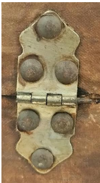
Fig. 63. Bisagra izquierda previo a la limpieza y retirada del óxido.
