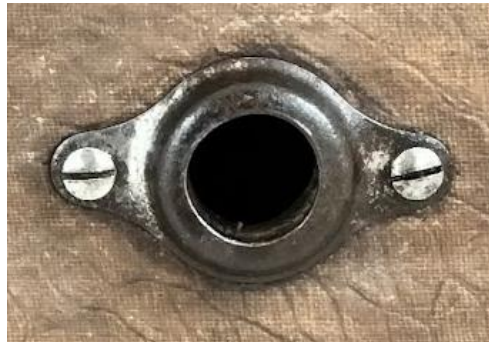
Fig. 73. Embellecedor del orificio de la manivela tras aplicar la protección de Paraloid® B-44 al 7% en acetato de etilo.
