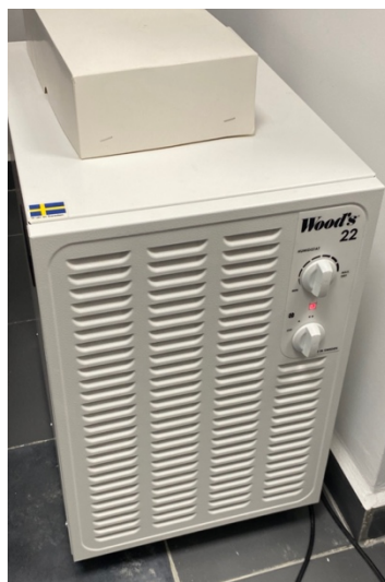
Figura 79. Deshumidificador instalado en la sala de almacenaje.
